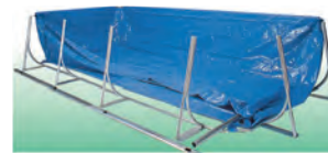
3 Montaje de los componentes superiores de la estructura metálica
